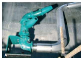
Obrázek 1A: Dvojitá tryska umístěná ve spodní části vyhnívací nádrže. B: Princip systému Rotamix® (verze bez horních trysek)
