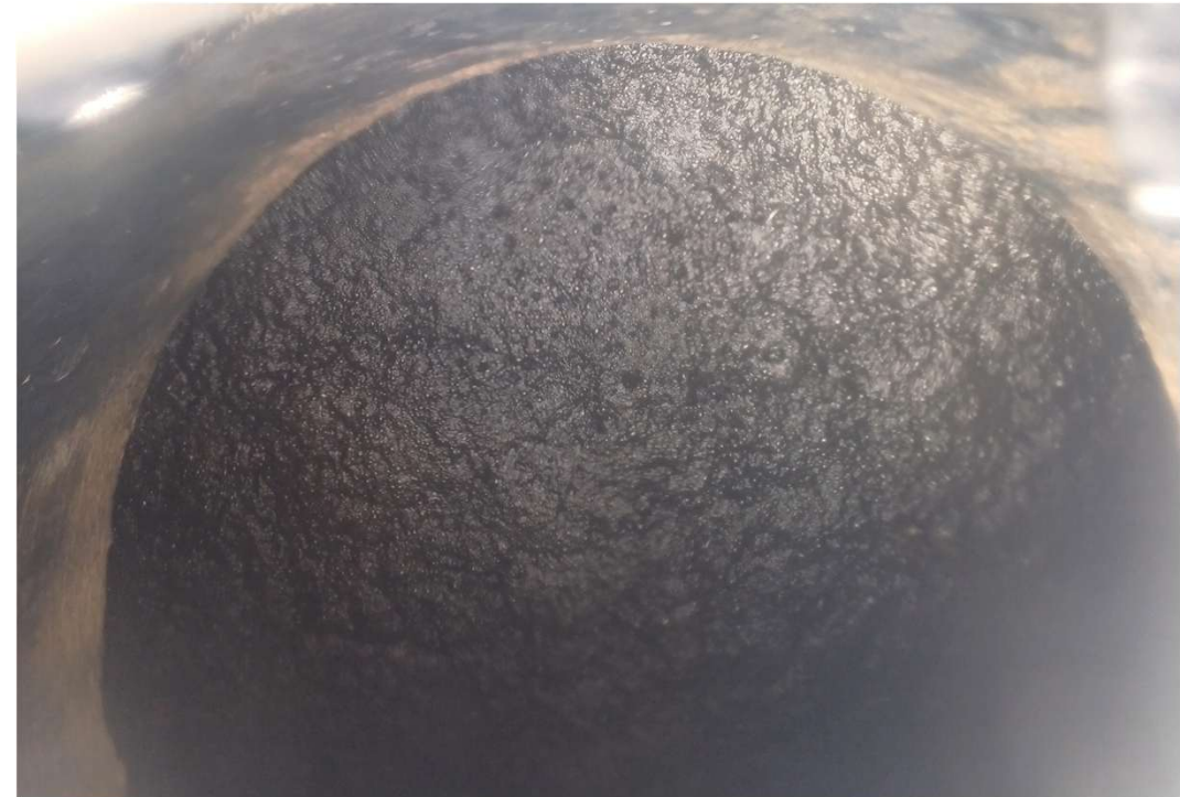
Pohled do fermentoru z vrchlíku, nad hladinou kalu jsou 4 m pěny
