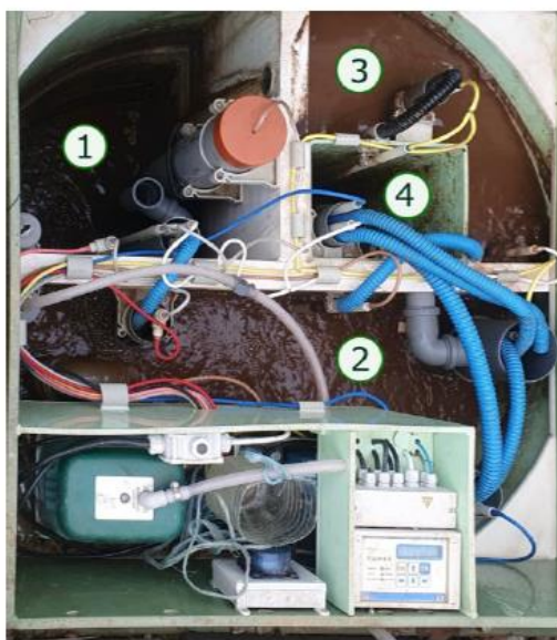
Aktivační domovní čistírna TOPAS S: 1 – přítoková nádrž (usazovací nádrž), 2 aktivační nádrž, 3 – kalojem, 4 – odtoková nádrž
